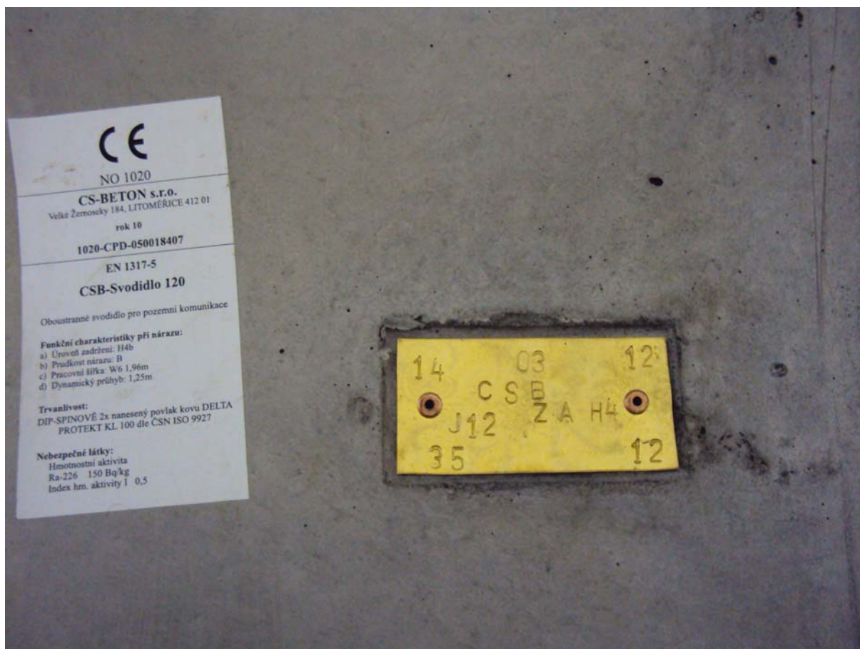
Obrázek 11 – CE štítek a mosazný štítek značení betonových svodidel CS BETON
