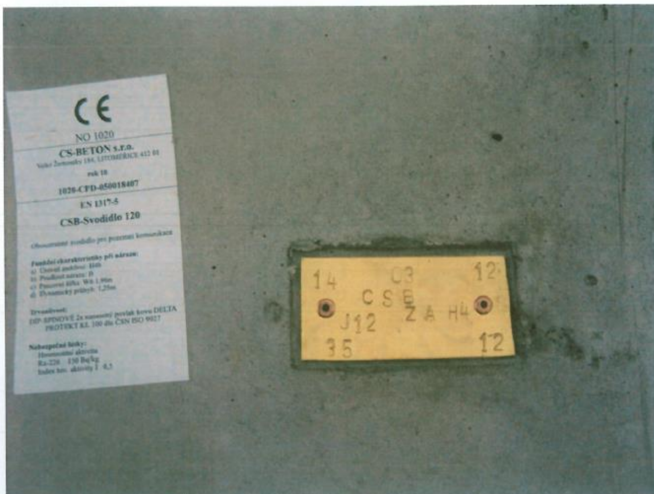
12. ábra - CE címke és sárgaréz címke a CS BETON betonkorlátokon
