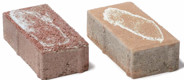
Dlažba s výkvětem
