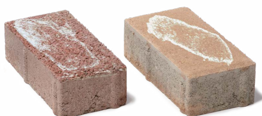
Dlažba s výkvětem
