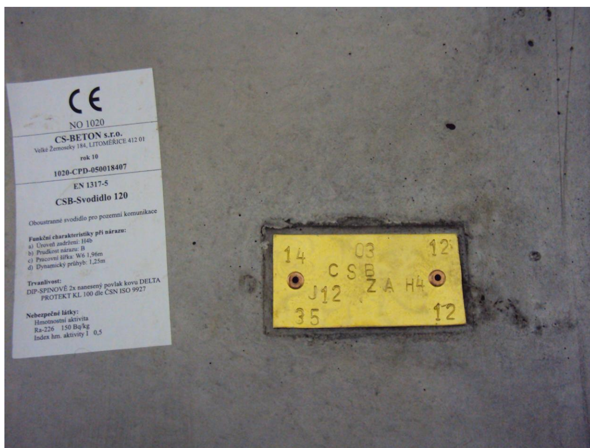
Obrázek 12 – CE štítek a mosazný štítek značení betonových svodidel CS BETON
