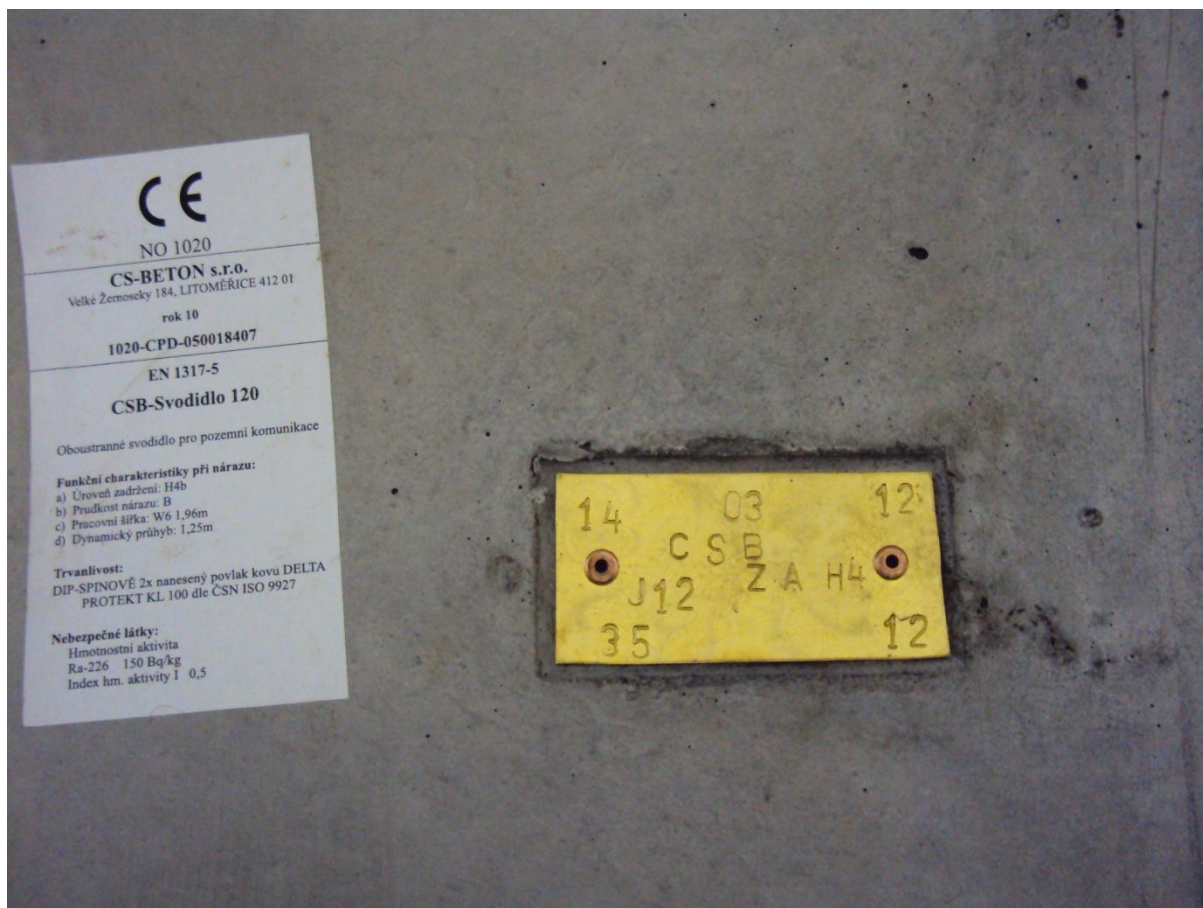
Rysunek 12 – Tabliczka CE i mosiężna tabliczka oznaczenia barier betonowych CS BETON
