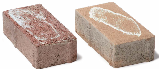
Dlažba s výkvětem
